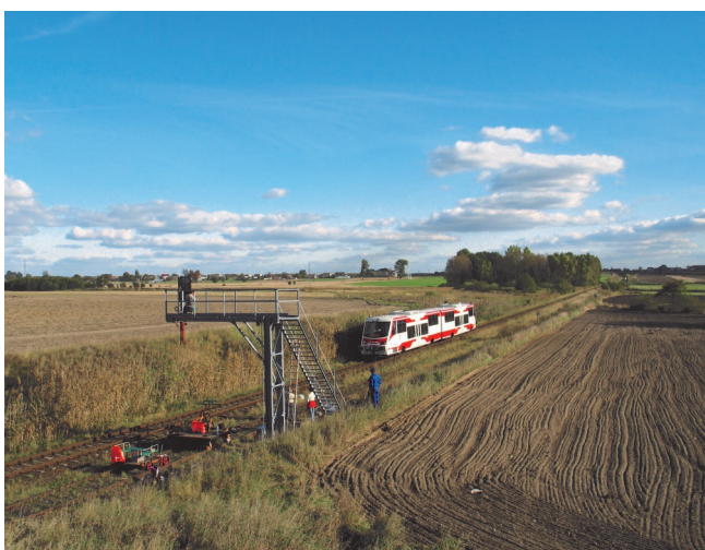
Fot. 1. Renowacja zabytkowego pomostu sygnałowego przeprowadzona przez członków Towarzystwa w 2007 roku.
